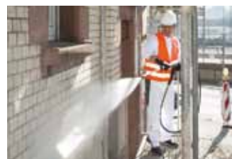
Gebäude- und Fassadenanierung.
