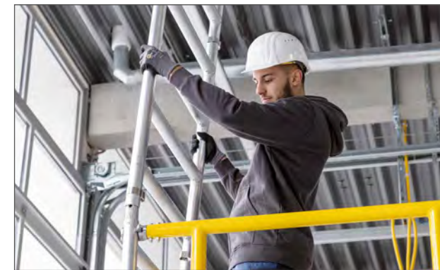
Weitere Aufsteckrahmen einsetzen
