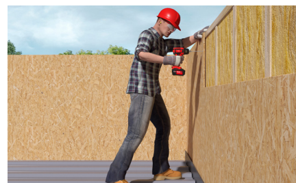
Befestigung von OSB-Platten auf Holzständern im Holzrahmenbau
