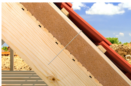
Aufdachdämmung
