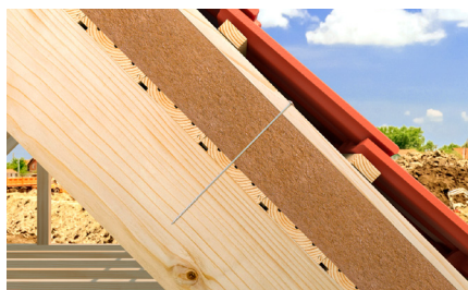
Nicht druckfeste Dämmstoffe in der Aufdachdämmung
